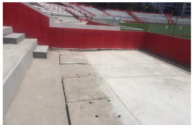
Fig. Alambrado (Misto alv/concreto + vidro)
