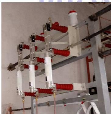
Fig. Seccionadora Fusível
