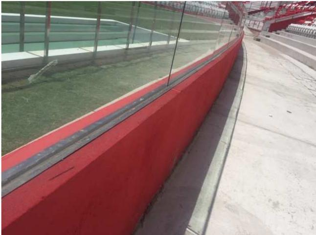
Fig. Alambrado (Misto alv/concreto + vidro)
