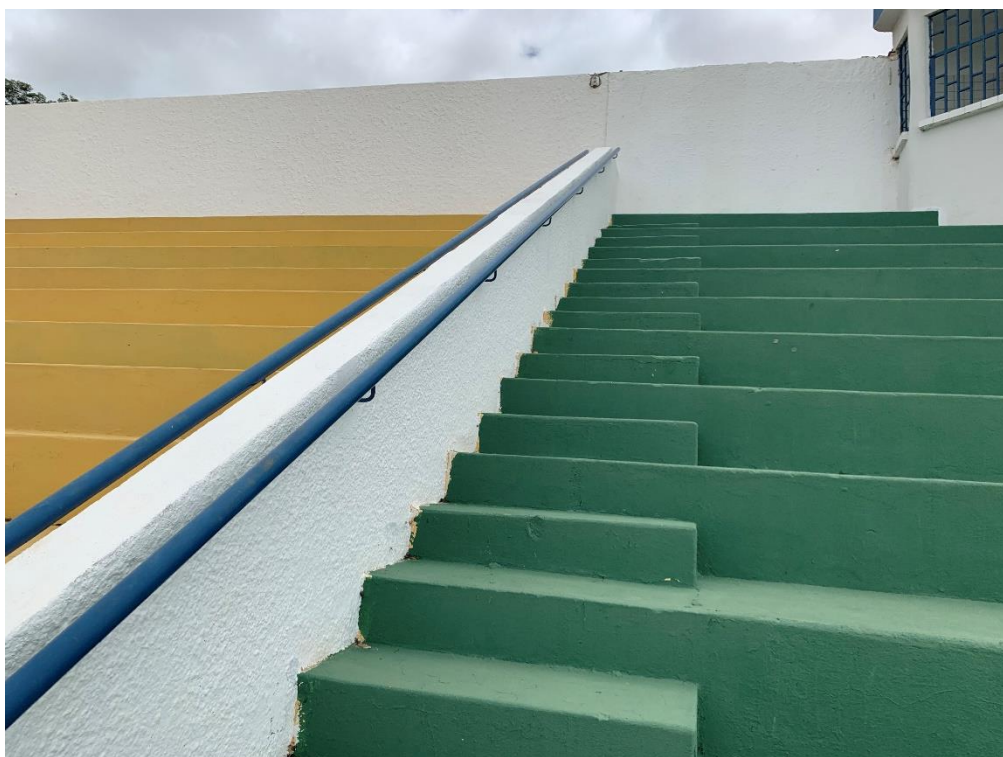
Figura 38- ESCADA PARA ACESSO A ARQUIBANCADA E CORRIMÃOS EM AÇO
