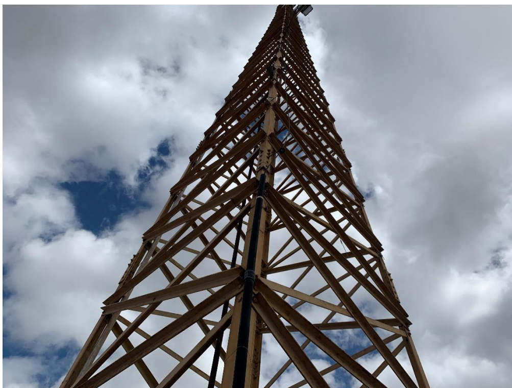
Figura 30- TORRE DE ILUMINAÇÃO - DETALHE DO SPDA FIXADO
