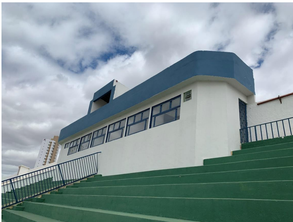
Figura 37- GUARDA CORPOS INSTALADOS EM ARQUIBANCADA
