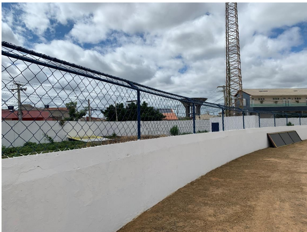
Figura 31- ALAMBRADO ACIMA DA ALVENARIA AO REDOR DO CAMPO DE JOGO
